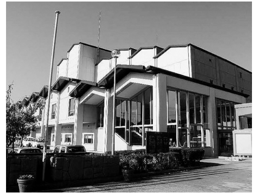
【外壁改修を予定する市民文化会館】
